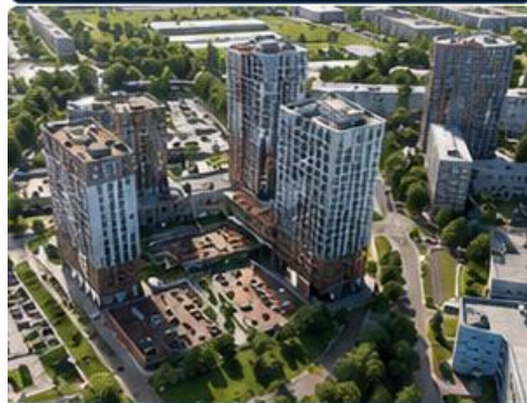
ЖК Моменты г. Екатеринбург Система водоснабжение
